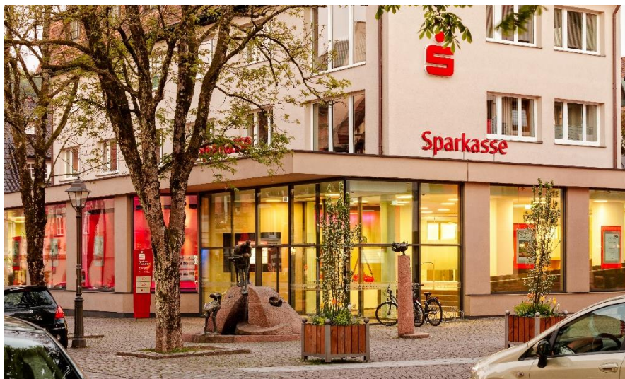
Bildunterschrift: Im Juni 2024 starten die Umbau-Arbeiten der Sparkassen-Hauptstelle in Haslach.
